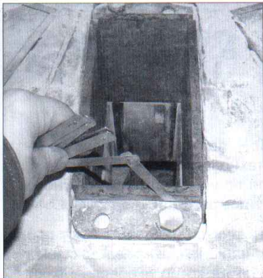
Рис. 4. Торцевые пластины установлены со слишком большим зазором
